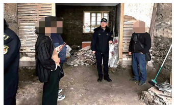
和专家的现场检查,业主解释称因急于入住,故先行开工。工作人员当场严肃告知:文博建筑装修必须坚持“先报备、后施工”原则,尤其是涉及
